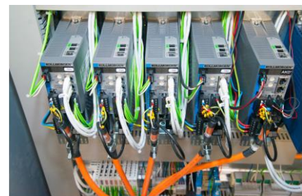
Die KOLLMORGEN Servoregler AKD lassen sich flexibel konfigurieren.
